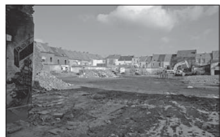
Afbraakwerken in de Brugse poort om plaats te maken voor het nieuwe park
