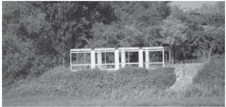
Het frame van één van de nieuwe vogelkijkhutten
